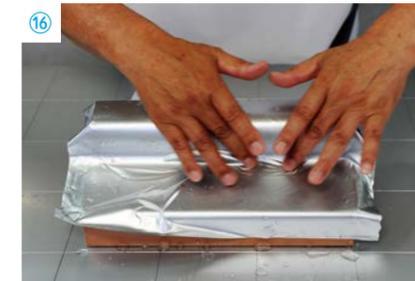
⑯ フィルム本体をかぶせましたら水の力を利用してフィルムを調節します。
