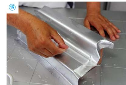
⑲ Rの部分も気泡と水分を逃がしながら密着させていきます。
